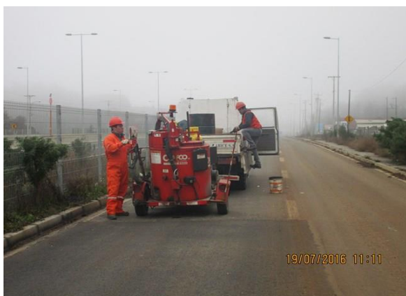
Sello de juntas en reparaciones de baches, Eje 5 y Eje 8, sector Cerro Alto.
